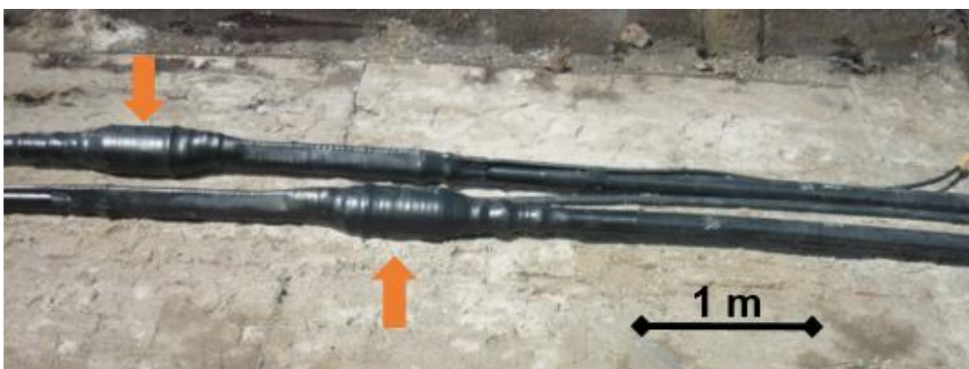
Abbildung 7: Muffen (Pfeilmarkierung) vor Wiederverfüllung des Leitungsgrabens 7
